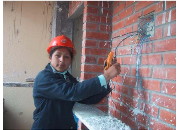
Maribel, eine Absolventin der Lehrlingsausbildung in Aldeas SOS und Fundación Pueblo bei der Überprüfung der Elektrik im Haus der Zukunft
