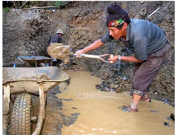
Beim Bau des Wassertanks
